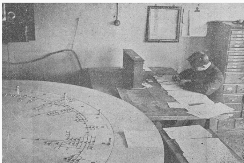
« Teléfono de llamada selectiva ». Detalle de las esquemas de la línea, dibujados sobre la mesa giratoria.—Al fondo puede verse el Controlador, en frente de la «Caja de llaves de llamada».
