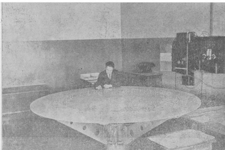
« Teléfono de llamada selectiva ». Vista general de los aparatos y de la mesa giratoria circular para el control de tres es.
